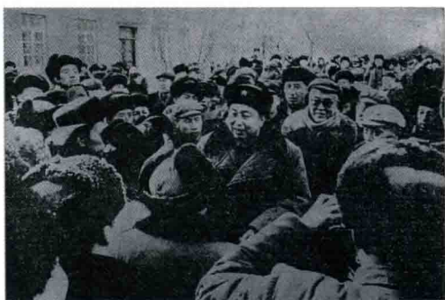
1975年2月4日，营口、海城地区发生7.3级强烈地震。2月7日，国务院副总理华国锋率中央慰问团到营口地震灾区慰问。
