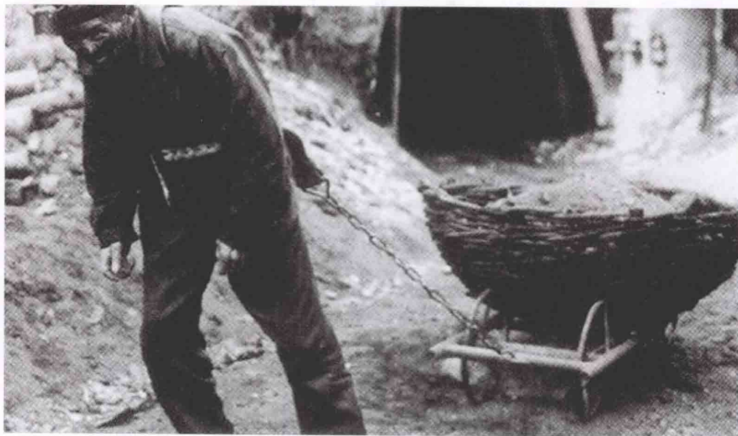
早期煤矿人工柳筐拉驮运煤出井
