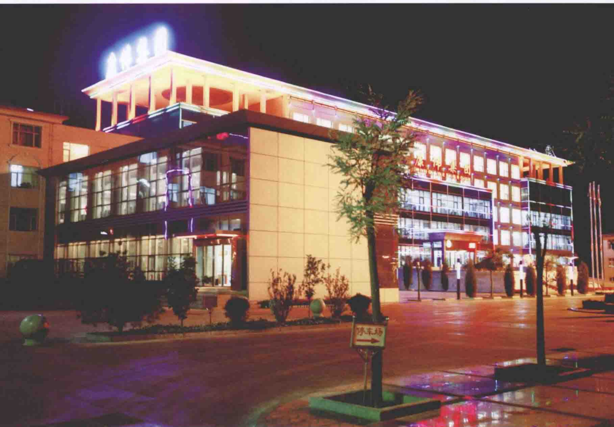
2010 年新建恢宏大气的办公大楼
