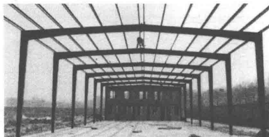
图 1-4 典型的门式刚架结构
