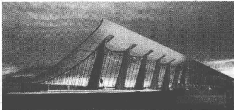
图 1-17 美国华盛顿杜勒斯国际机场航站楼
