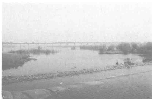
图0-1-6 跨越西安浐灞湿地公园的铁路桥 (高冬光,2014年4月摄)
