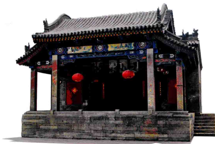
源于明代的卷棚顶、立卧栏木结构，明代雀替，清代彩绘戏台
