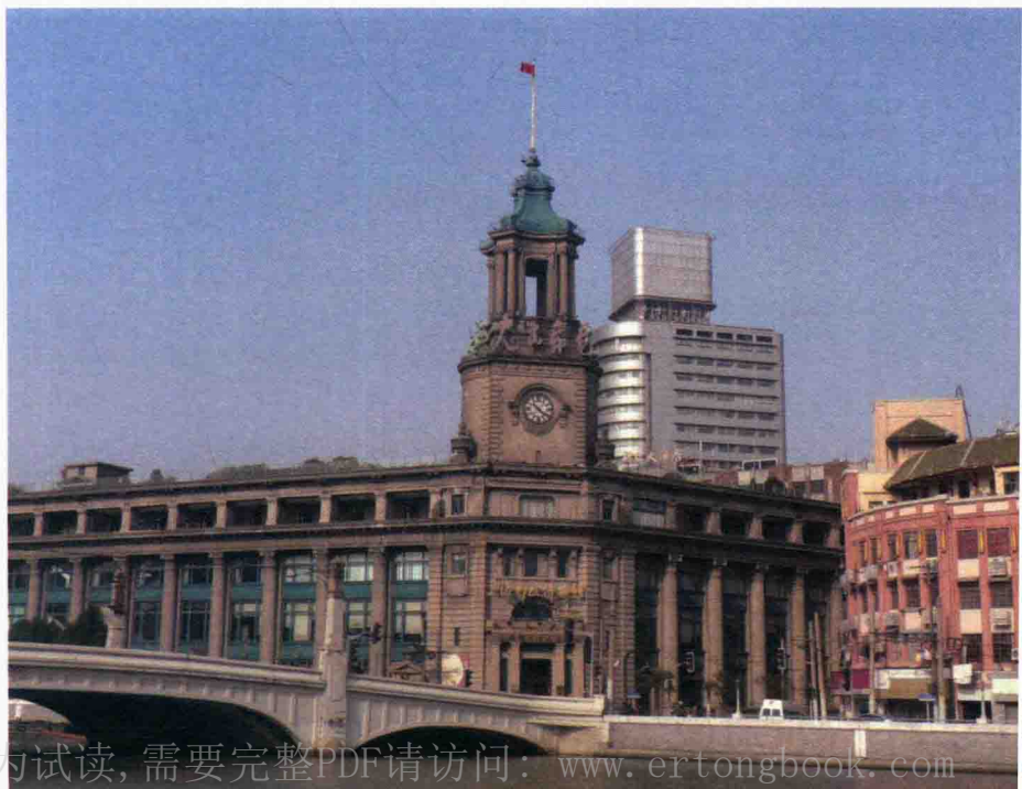
邮政总局大楼
