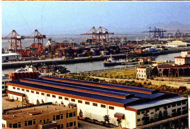
厦门地区直面大海, 沿岸拥有潮滩、沙滩等丰富的海岸地貌(上图), 而绵长的海岸线又为其建设运输能力强大的港口奠定了基础, 厦门港成为中国东南沿海地区的重要军港和货物集散商埠(下图)。
