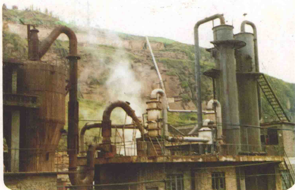
万县磷肥厂硫酸车间。向世荣摄
