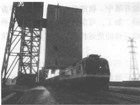
图 1-8 曹妃甸港火车疏港
