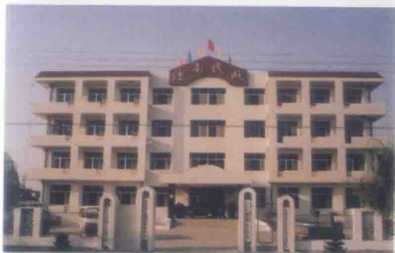
滦南县民政局办公楼
