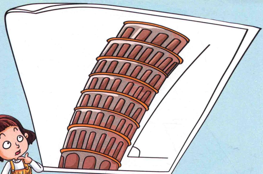
较硬，软的那边就开始塌陷，硬的那边没有丝毫的变化，所以比萨斜塔就开始往软的那边倾斜，而且倾斜得越来越厉害。最新的挖掘表明，钟楼建造在了古代的海岸边缘，因此土质在建造时便已经沙化和下沉。
