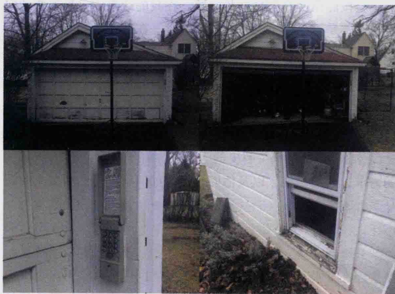
图1 车库门的问题。开门的小键盘在冬天被冻住了，我没请人来修，而是从窗户爬进车库，把开门系统换为手动的。
