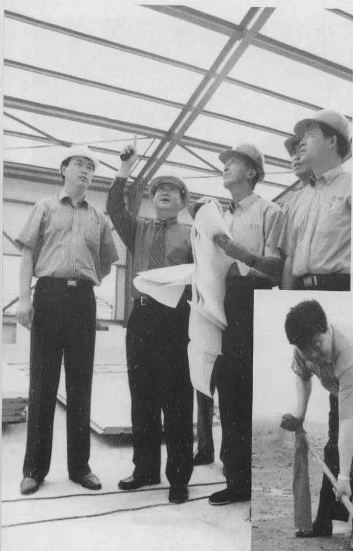
● 韩召善在中韩合资自动化防撬门生产线施工现场
