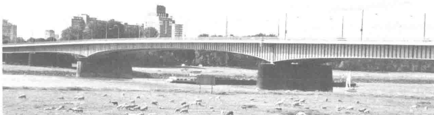
图 1-2 德国杜塞尔多夫—诺伊斯桥(Düsseldorf-Neuss Bridge)
