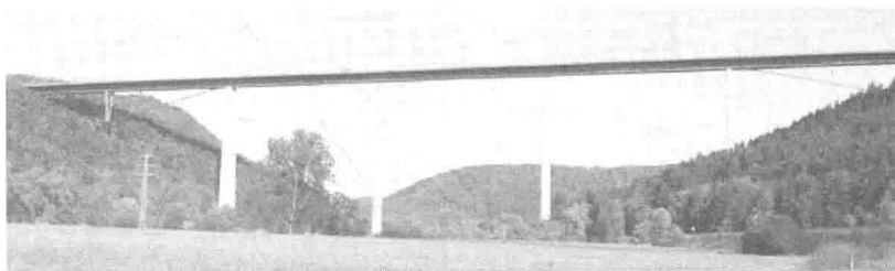
图 1-4 德国内卡河谷桥(Neckartal Bridge)
