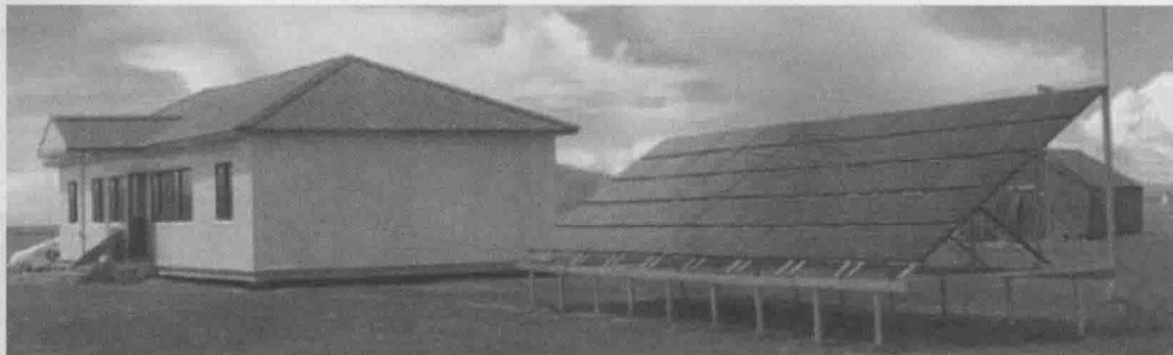
图 1.1.1 独立光伏发电系统
