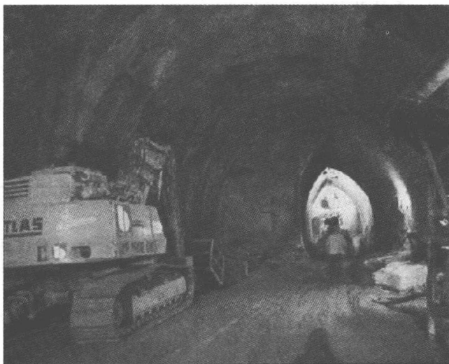
图 1.3 采用“新奥法”的隧道施工现场
