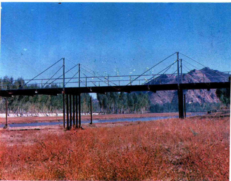
平泉县党坝至倪杖子钢木结构斜拉桥
