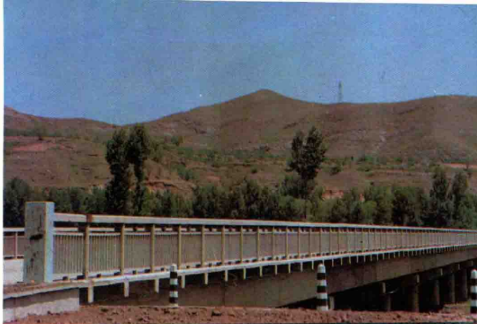
京承旅游公路 滦河特大桥
