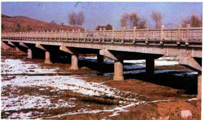
平双公路龙潭 沟大桥
