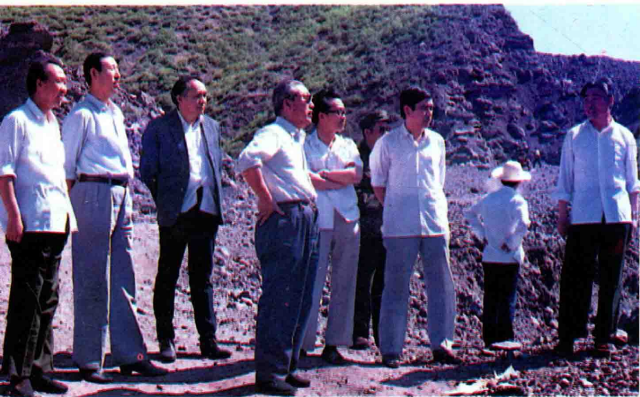
徐寿林副厅长、王高鹏副专员视察青石梁大爆破工地现场
