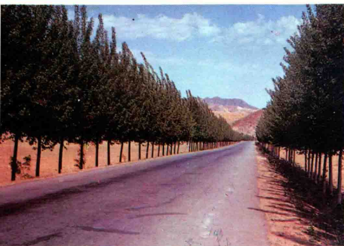
宣唐线白塔东 沟段公路绿化
