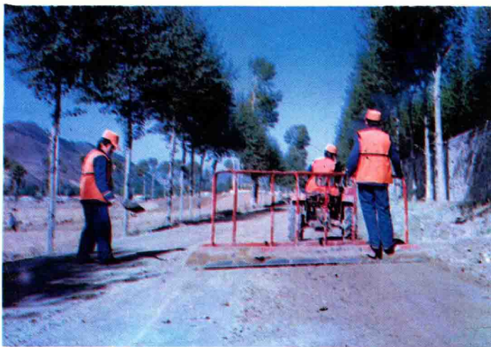
养路道班工人 用自制的刮平 器刮平路面
