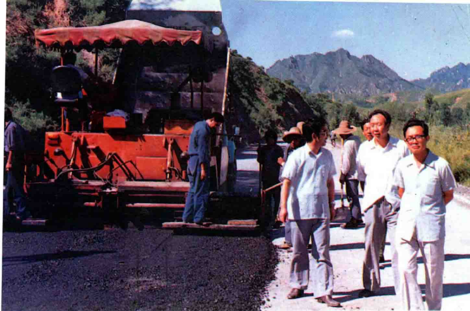
何少存副厅长察看摊铺机铺筑路面现场
