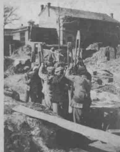
图 12 新门诊部打地基照片
