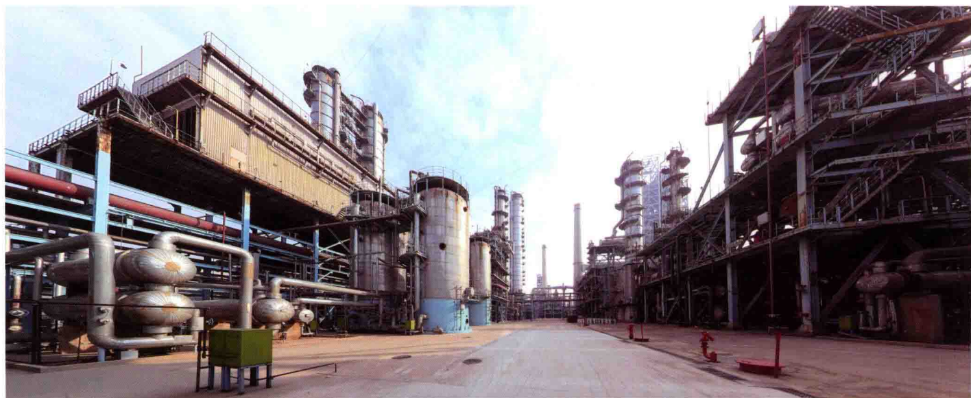
▲ 中国北方最大化纤生产基地—中国石油辽阳石化分公司
