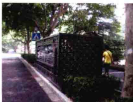
10 千伏姜家园线样板工程
