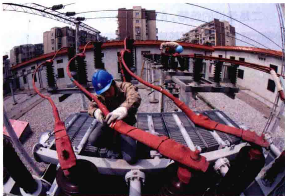
对电网设备进行消缺
