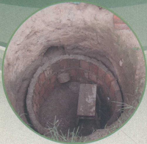
正在修建中的双瓮漏斗厕所
