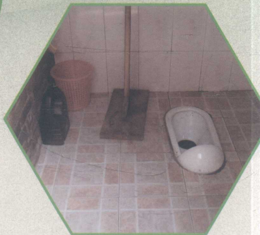
已经建好的双瓮漏斗厕所
