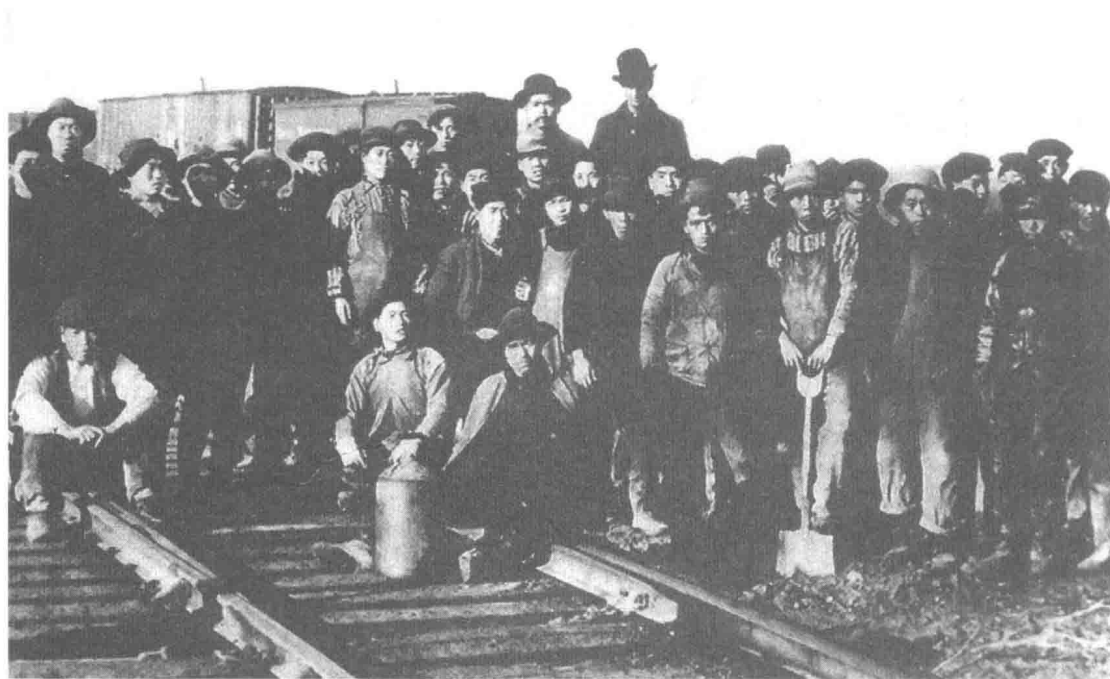
1881年加拿大修筑横贯北美大陆最长的铁路，数以万计的华工充当筑路工人，其中四千多人献出了生命。图为工地上的华工。
