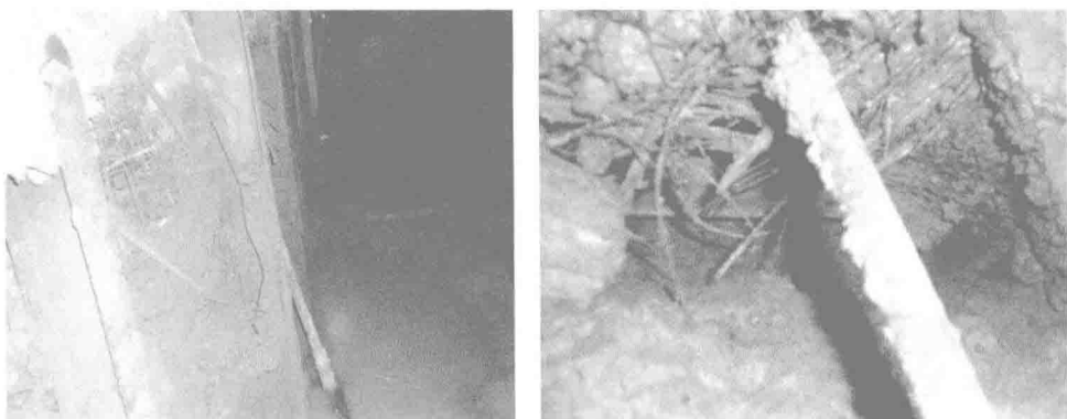
图 1-3 边墙隆起及变形破坏
