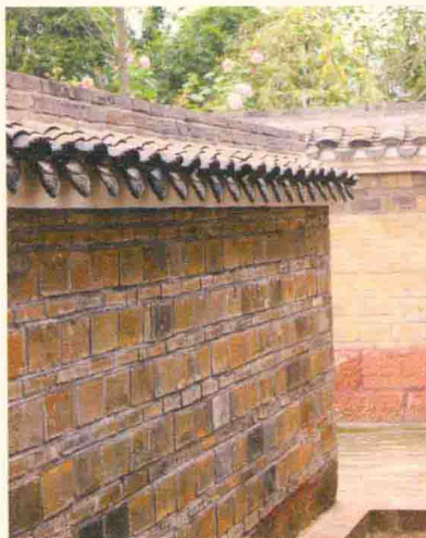
上空斗下石料墙
