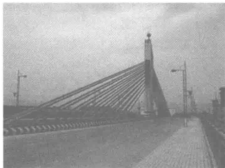
图 1-14 平顶山市湛河一桥
