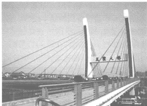
图 1-9 余姚市兰墅大桥
