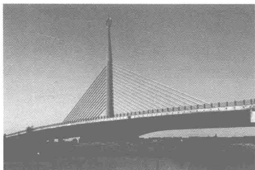
图 1-12 昆山市吴淞江大桥
