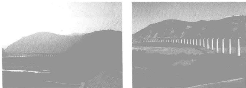
图 1.4 陇海线下行蔡阳川渭河特大桥
