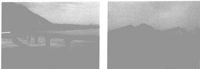
图 1.5 侯西线禹门口黄河大桥
