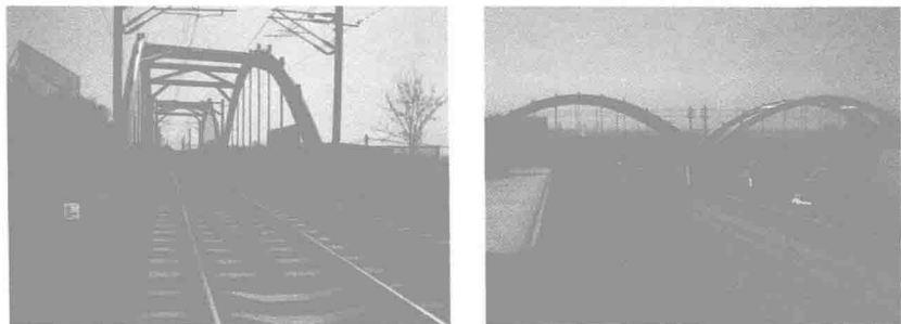
图 1.10 西安枢纽北环线梁村中桥
