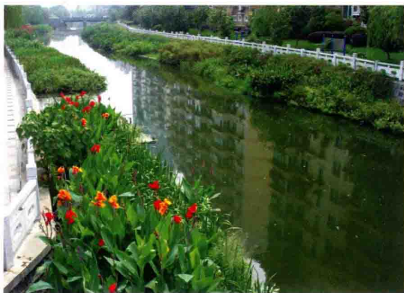
彩图22 生态浮岛软化生硬的河道岸线
