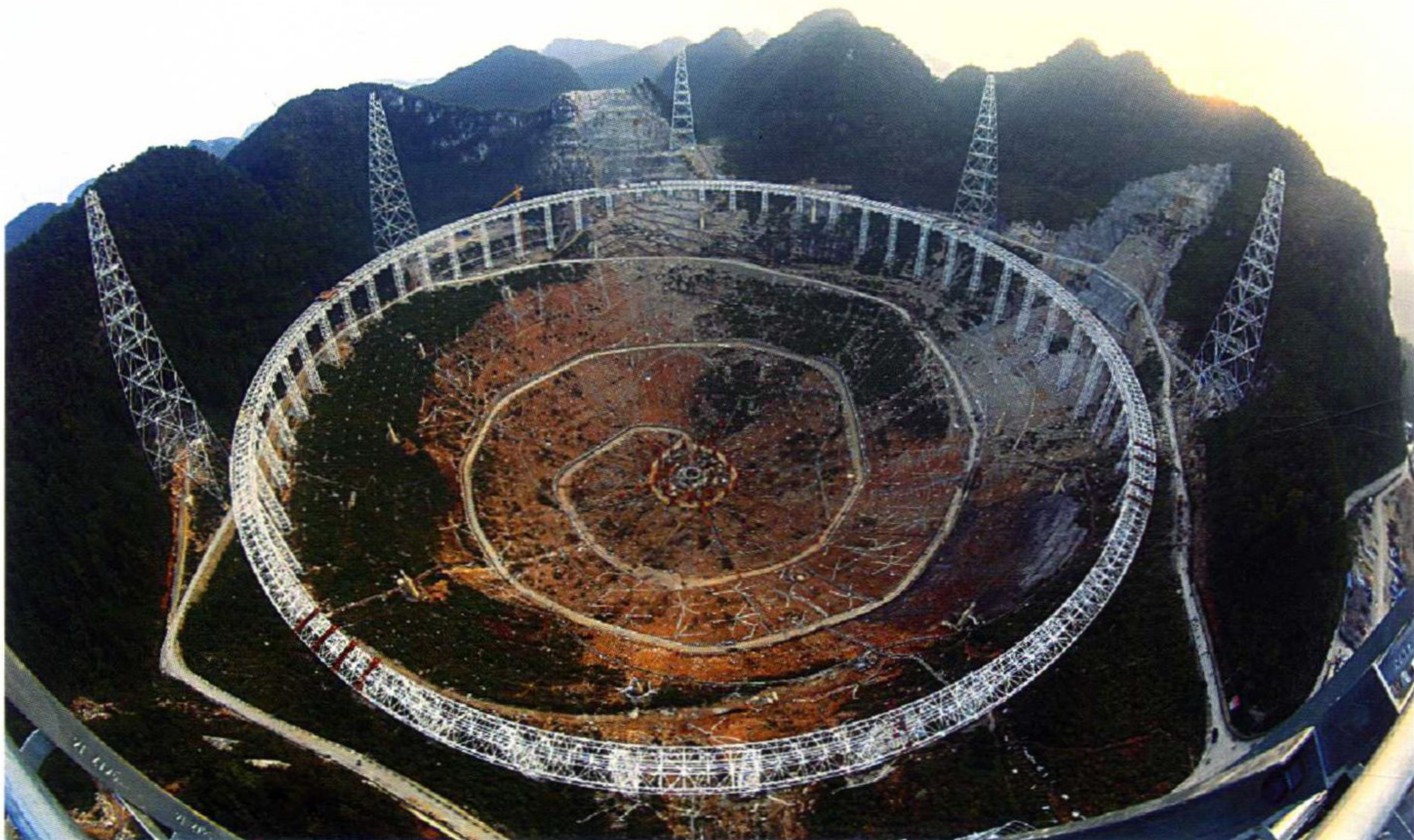
平塘县正在建设中的迄今为止世界上最大的射电望远镜 (代传付 摄)
