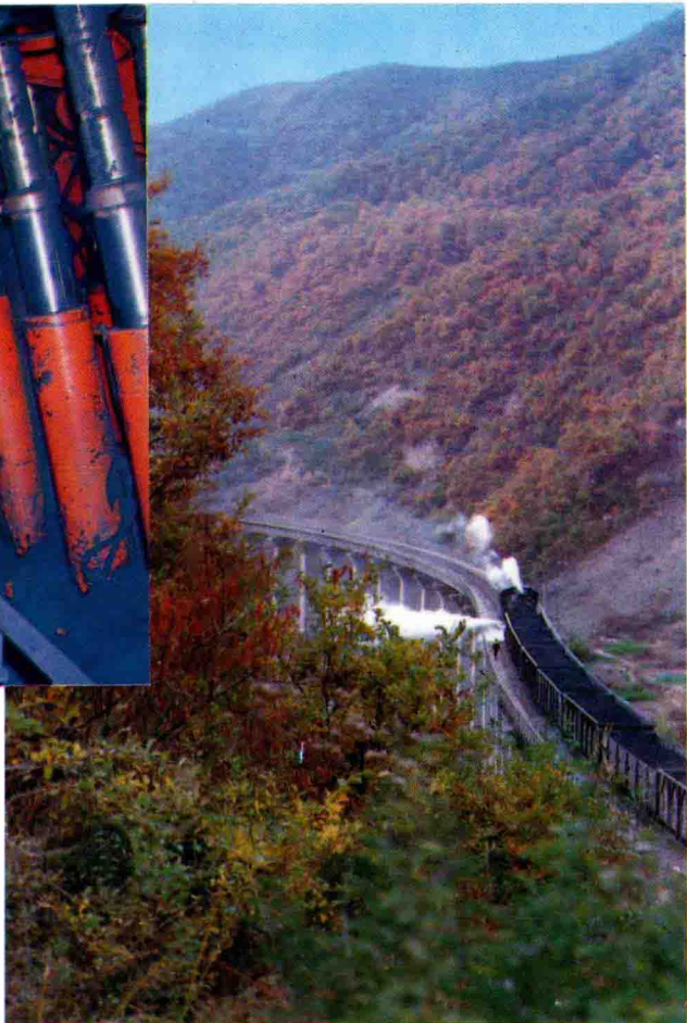
▲运煤铁路专用线
