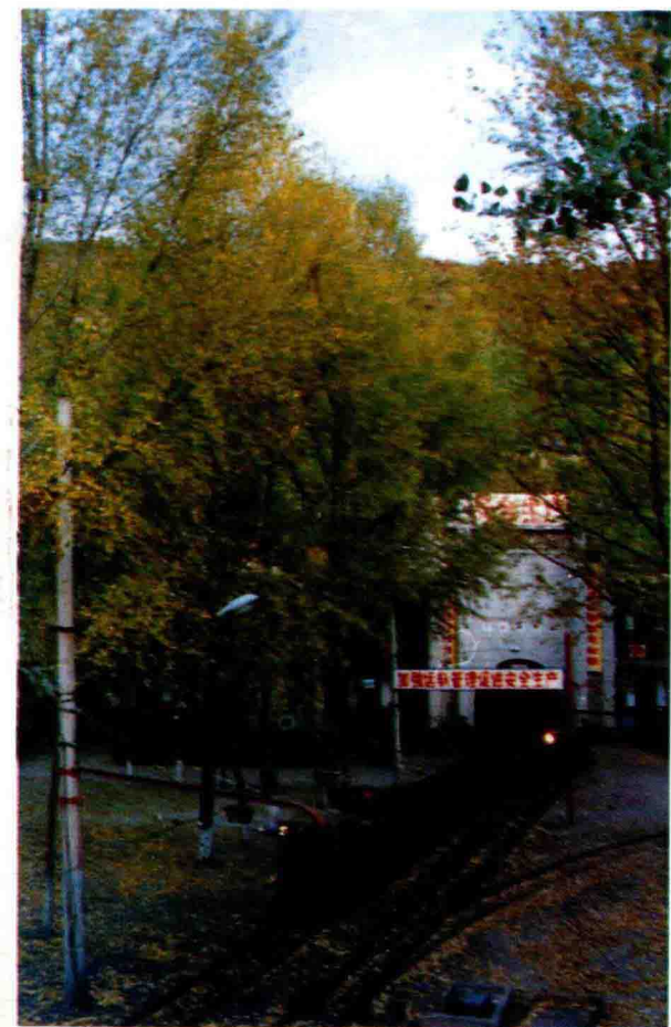
◀ 下石节煤矿平硐井口
