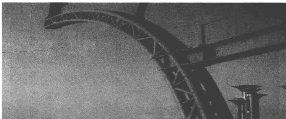
图 10 弧形钢管桁架设计
