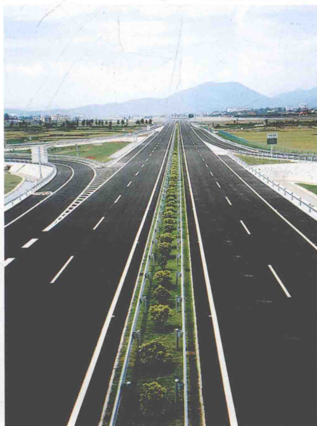
福泉高速公路枫亭路段
