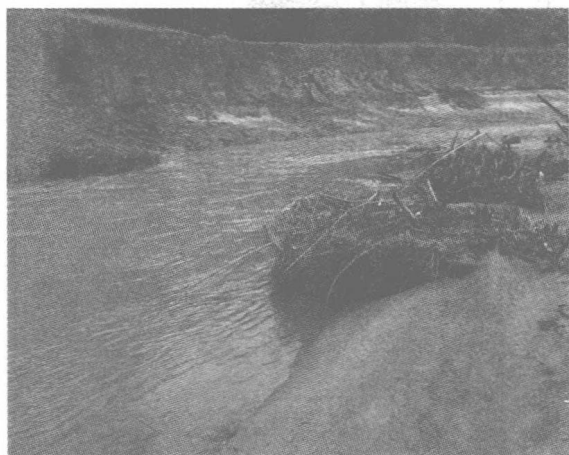
严重的水土流失
