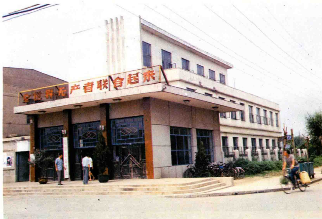
▲ 辽阳县总工会办公楼
