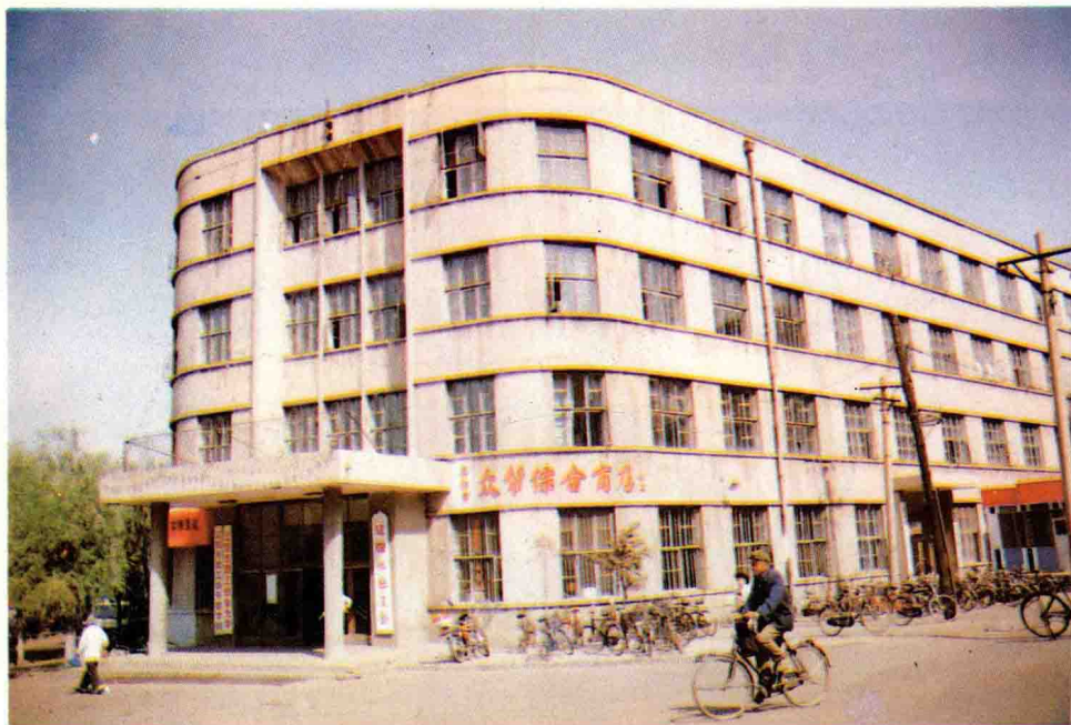
▲ 辽阳市总工会办公楼 辽阳市职工工业余大学教学楼
