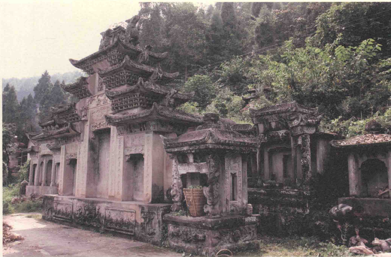
五郎坡杜氏墓全景
