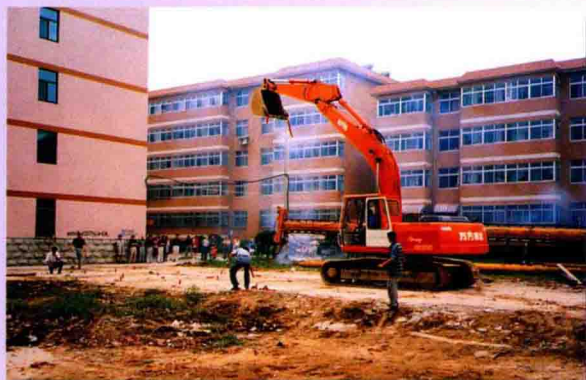
2001年9月16日，德州创业中心大楼开工建设。
