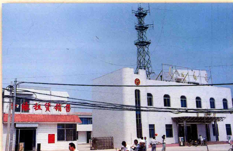
临盘邮电支局大楼
