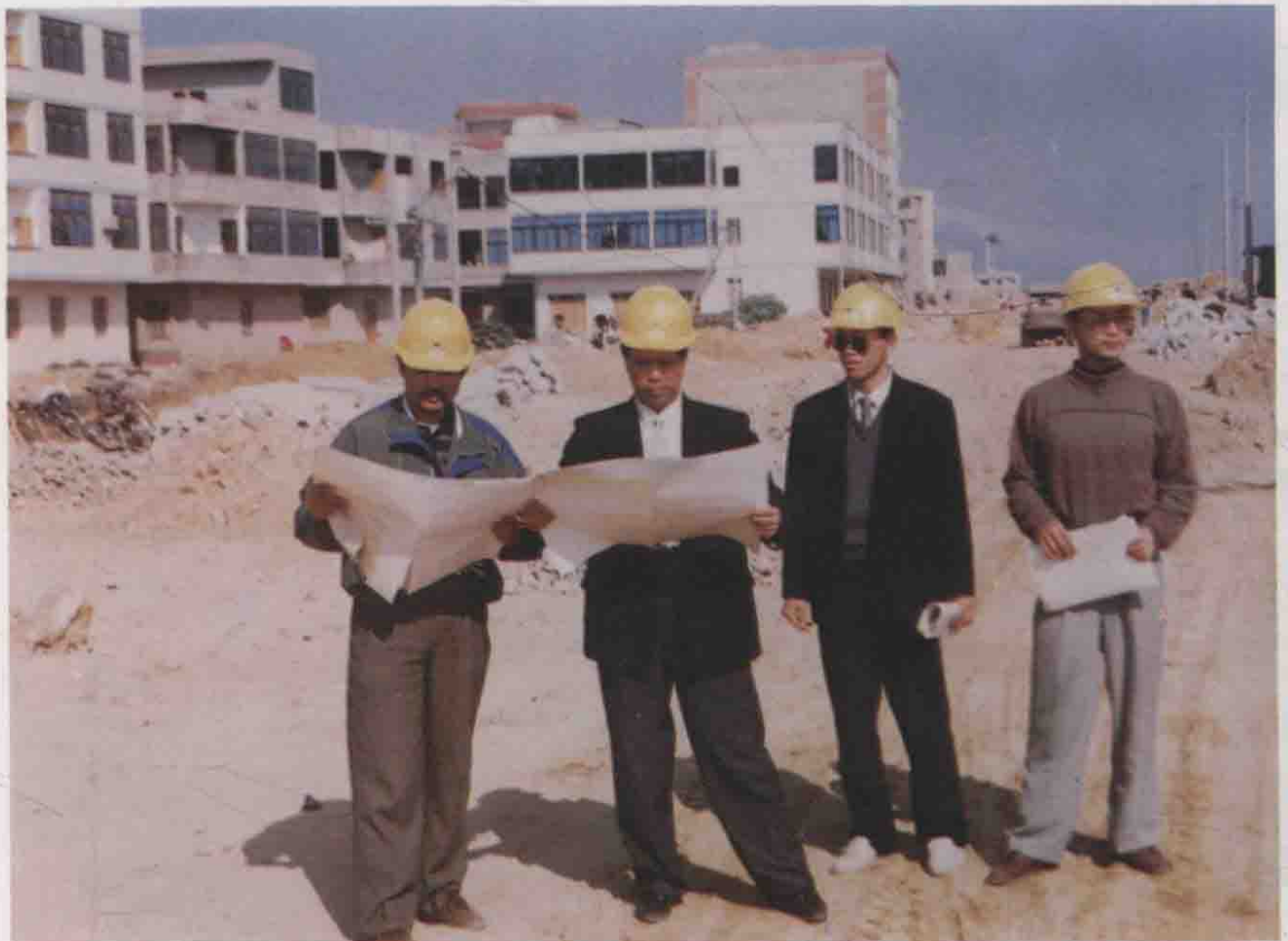
↑ 县建行贷款支持修建柏油路工程
