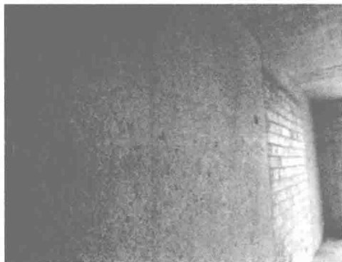
图1-2 混凝土墙面基层喷浆效果图
