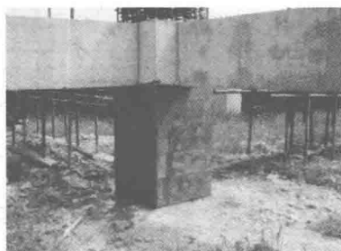
(b) 加固混凝土柱
