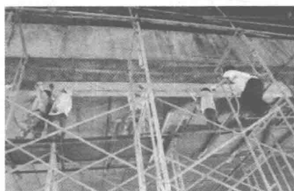
(a) 加固桥梁
