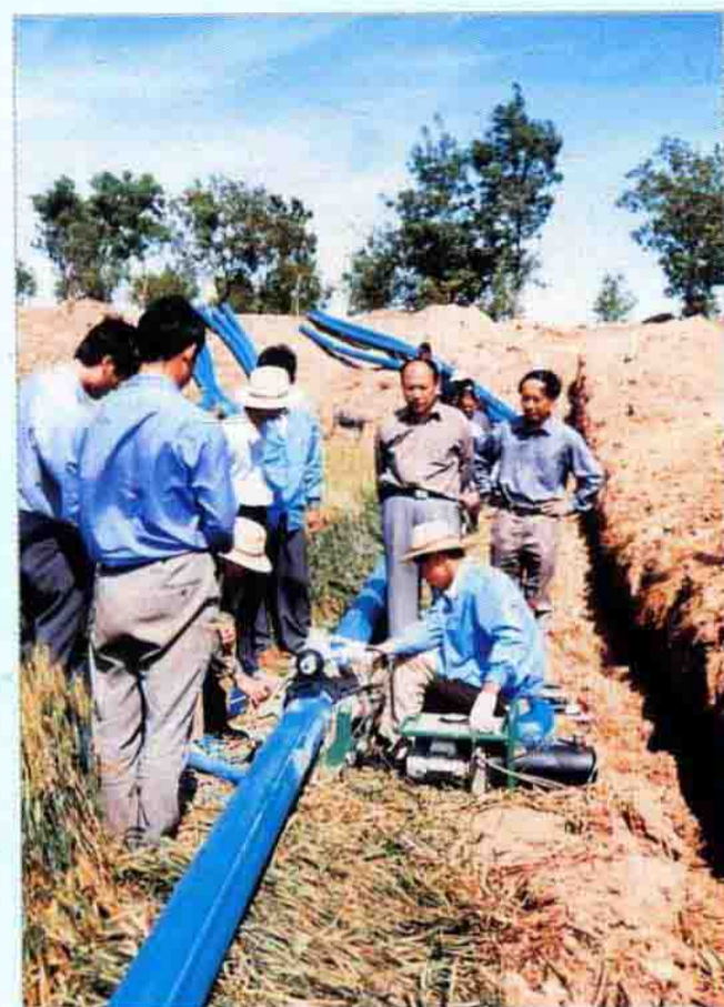
铺设低压节水管道
