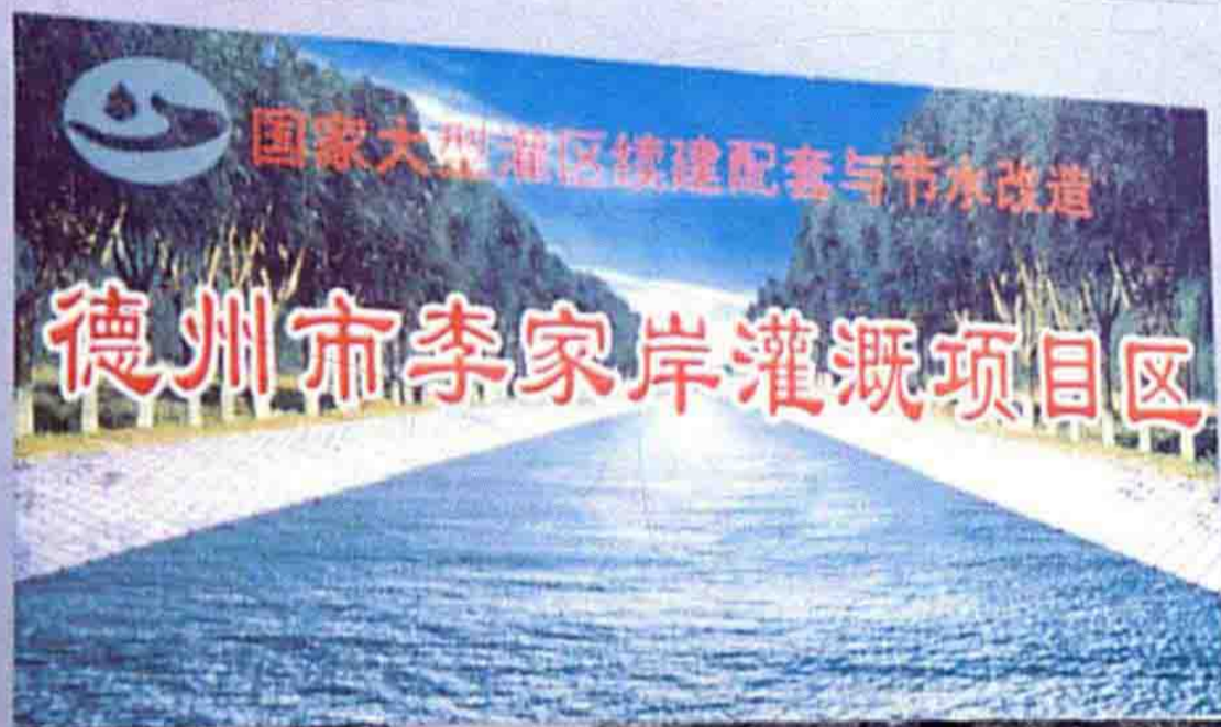
李家岸节水灌溉项目示范区
