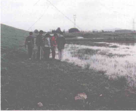
(a) 北苕溪下游近北湖防洪大堤的滞洪区
