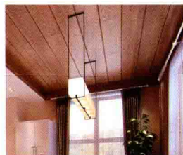
P50 松木板吊顶
