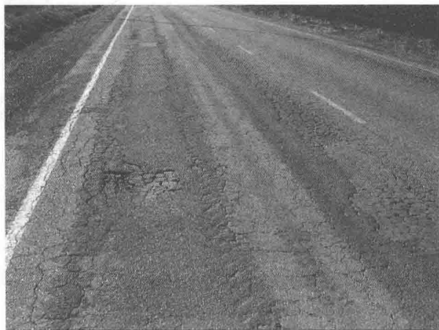
图 1.4 疲劳裂缝
