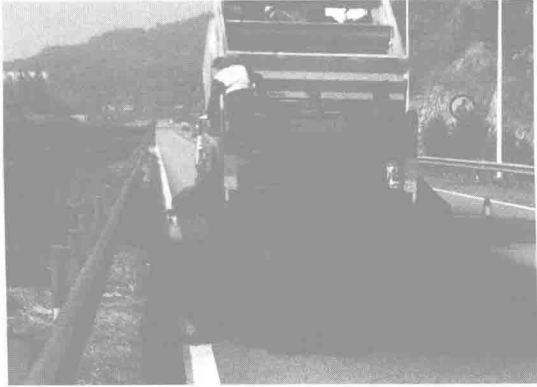
图3 同步撒布砂砾与洒布雷诺锋
