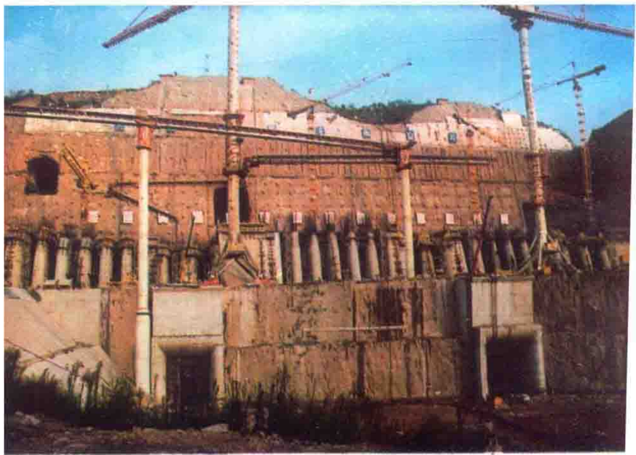
建设中的小浪底工程·洞群
