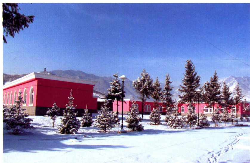
2008 年新建的省和政府疗养院休养区一角(王延林 供稿)
