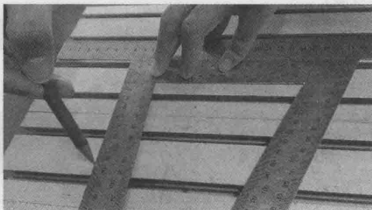
图 1-9 确定安装底板水平尺寸的方法
