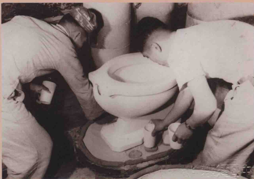
圖31：北投陶耐廠產品裝窯狀況舊照，臺灣工礦公司提供。
