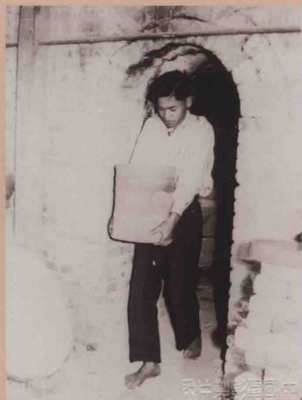
圖33：北投陶耐廠產品出窯狀況舊照，臺灣工礦公司提供。
