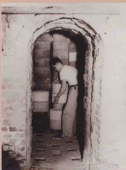
圖30：北投陶耐廠產品裝匣鉢狀況舊照，臺灣工礦公司提供。
