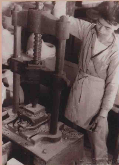
圖9：衝壓成形過程舊照，臺灣工礦公司提供。
