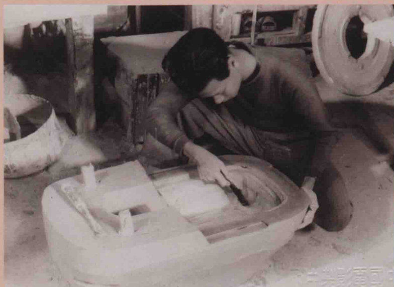
圖12：北投陶耐廠馬桶製作石膏模型的舊照，臺灣工礦公司提供。
