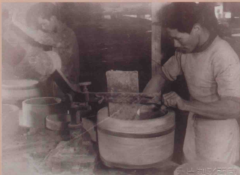
圖10：仰銼壓法製作匣鉢，臺灣工礦公司提供。
