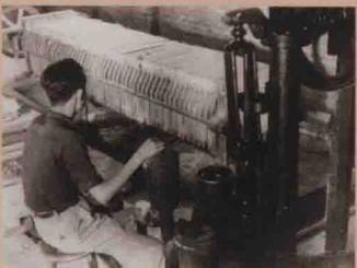
圖5：北投陶耐廠的壓濾機舊照。臺灣工礦公司提供。
