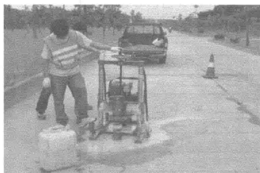
图 1-1 路面取芯钻机
