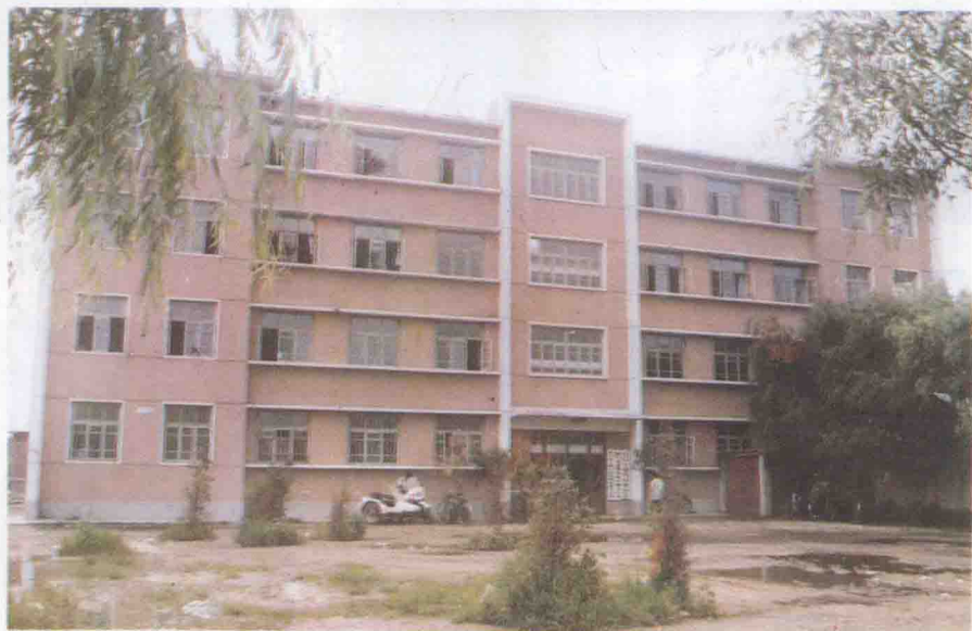
营口市工商局西 市分局办公地址
